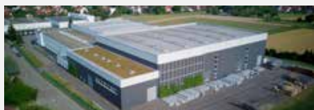
Hugo Brennenstuhl GmbH & Co. KG Werk 2 / Factory 2 / Impianto 2
